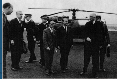
Visite du général de Gaulle lors de la construction de Port-Leucate
